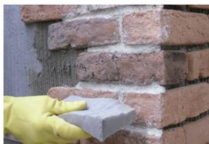
2. Faça a limpeza em etapas, a cada **06 peças**, no prazo máximo de 30 minutos para evitar que os resíduos sequem totalmente sobre a peça causando manchas. Limpe com uma esponja úmida, utilizando apenas água e sabão.
