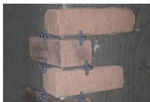
Devem ser assentadas seguindo a figura ao lado, uma peça para cada lado da quina e alternando as fiadas com peças de 10 cm de largura com peças de 20 cm de largura.
